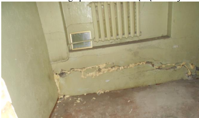
Att.Nr.7 - Nozīmīga plaisa no dzīvokļa Ģimnāzijas 25-6a puses
