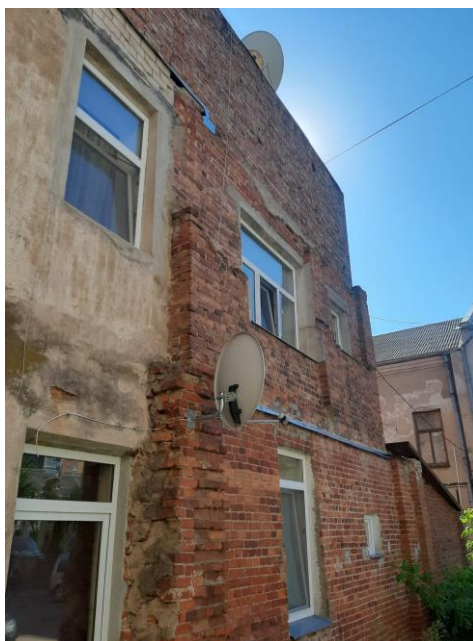
Foto Nr.12. Metāla elements nesošās sienas pastiprināšanai.
